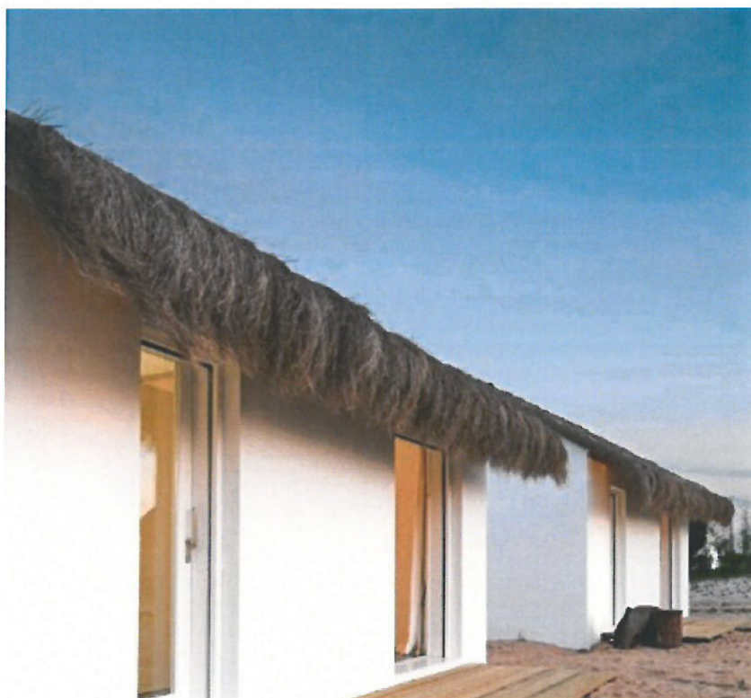
Fig. 11 – Imagem do tipo de Cobertura a Aplicar
